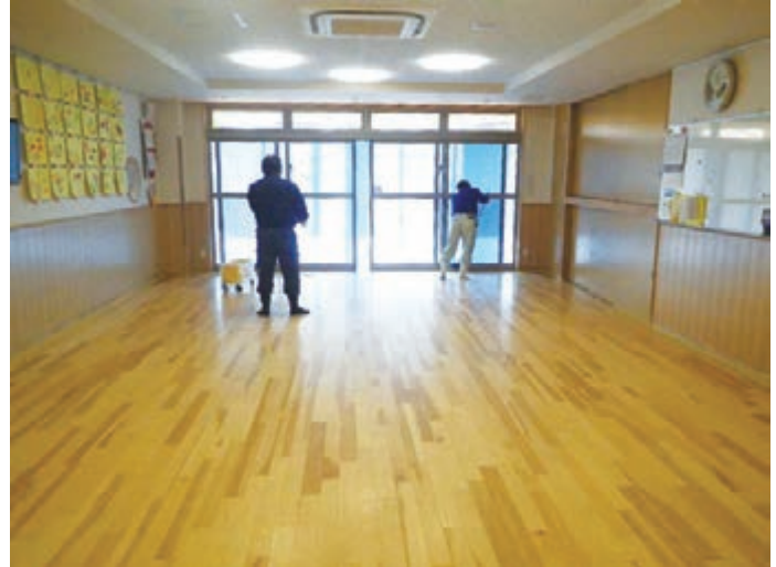
②外からの紫外線が入らないようにシートで養生の上、樹脂を塗布します。
