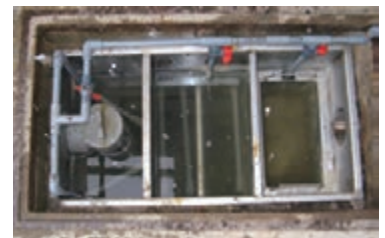
施工2日後(エアーポンプ停止)
