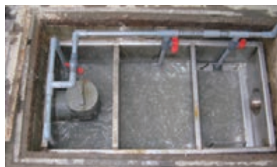
施工2日後(運転中)
