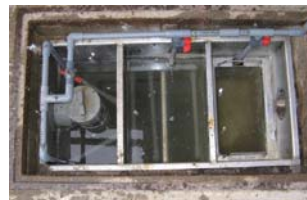
施工2日後(エアーポンプ停止)
