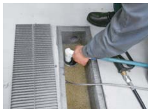
施工中(給食室高圧洗浄中)
