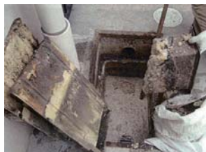
施工中(グリストラップ洗浄)
