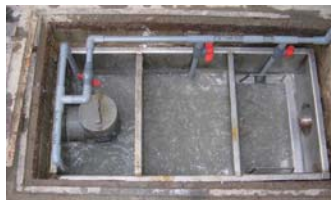
施工2日後(可動中)
